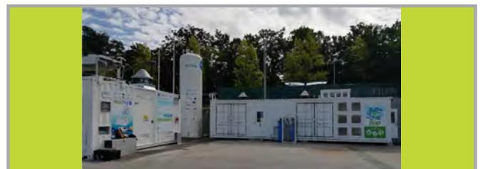
Abb. 4: Installierte Wasserstofftankstelle in Nantes (PEM-Elektrolyse links im Bild)
